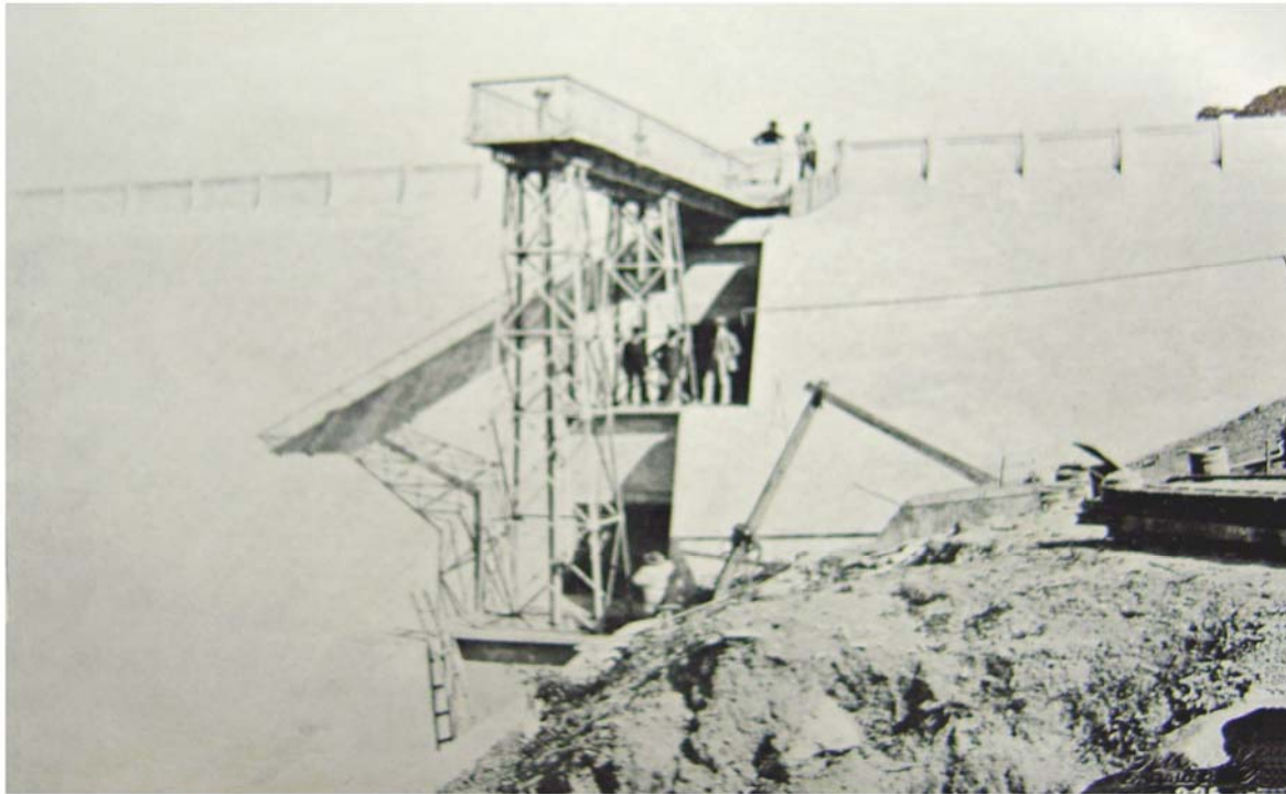
Barragem do Guaraú
