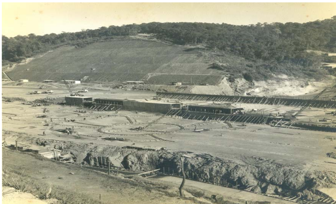
Figura 33 - Início da construção da E.T.A Guaraú, na década de 70, acervo SABESP
