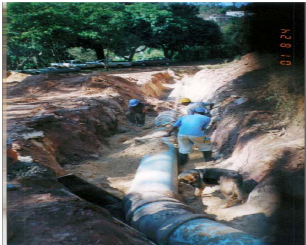
Figura 47 - Colocação da nova adutora - Foto de 2001, acervo Hagaplan Engenharia.
