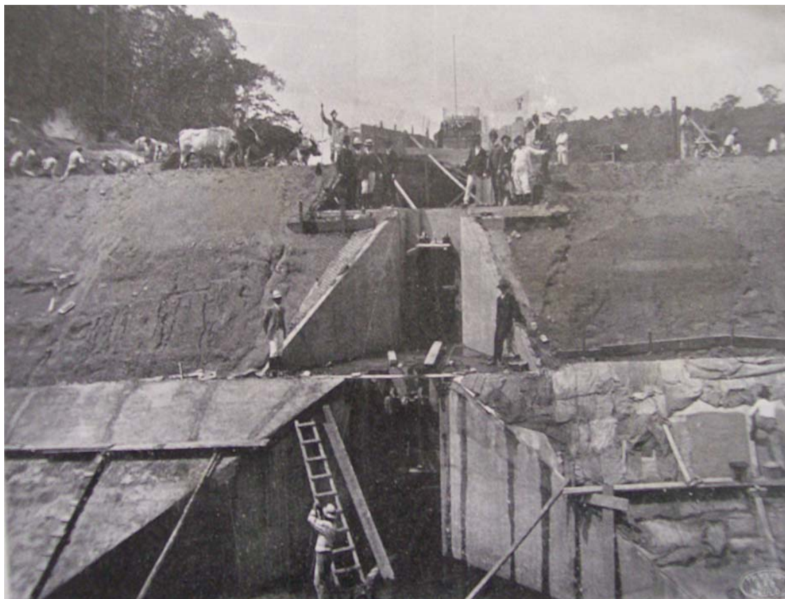
Figura 13 - Foto de 1906, construção da barragem do Engordador.
