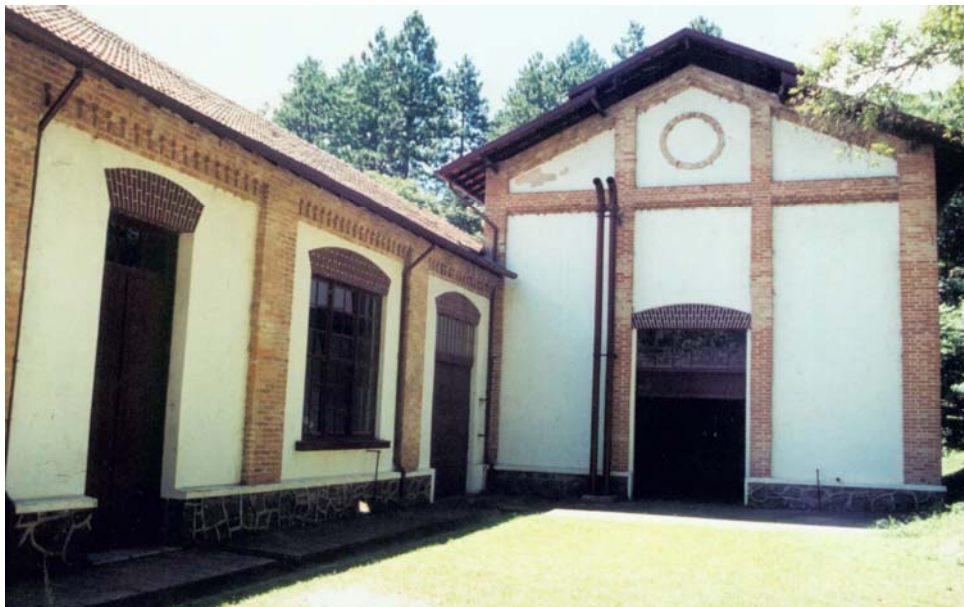
Figura 22 - Casa da bomba secundária 2007
