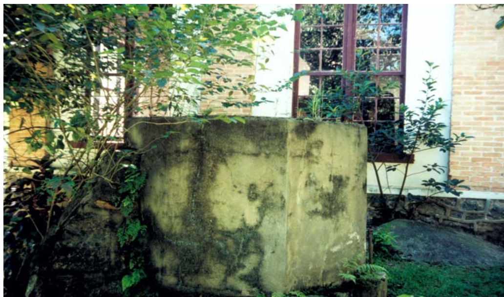
Figura 25 - Parte da estrutura da Chaminé 2004
