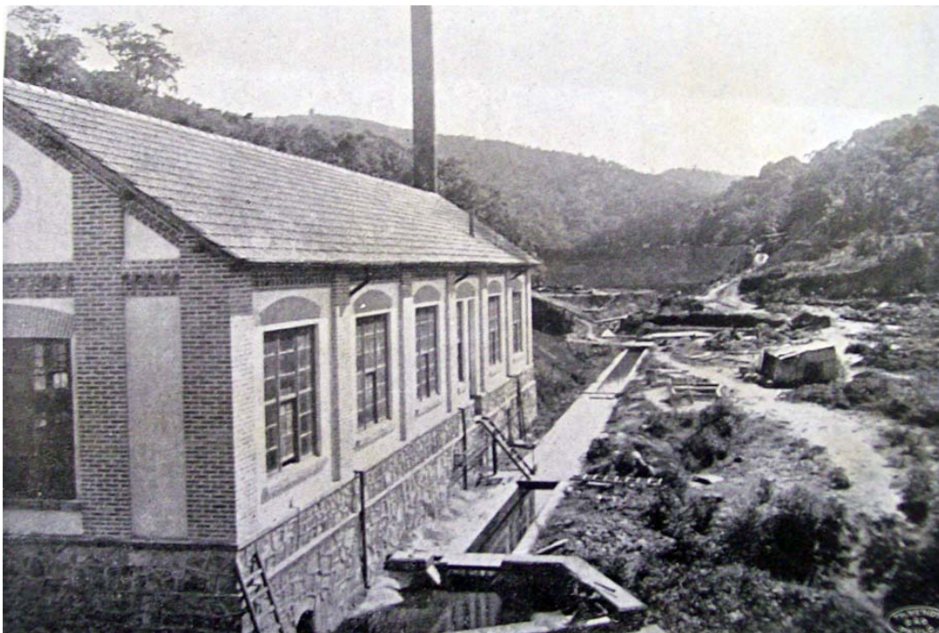
Figura 21 – Casa da bomba principal
