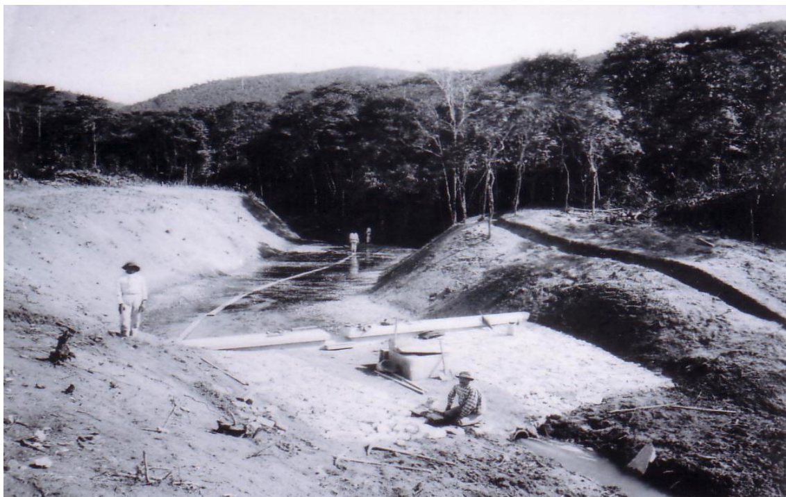
Figura 12 - Foto P.Doumet 1894. Construção da pequena barragem do Engordador
