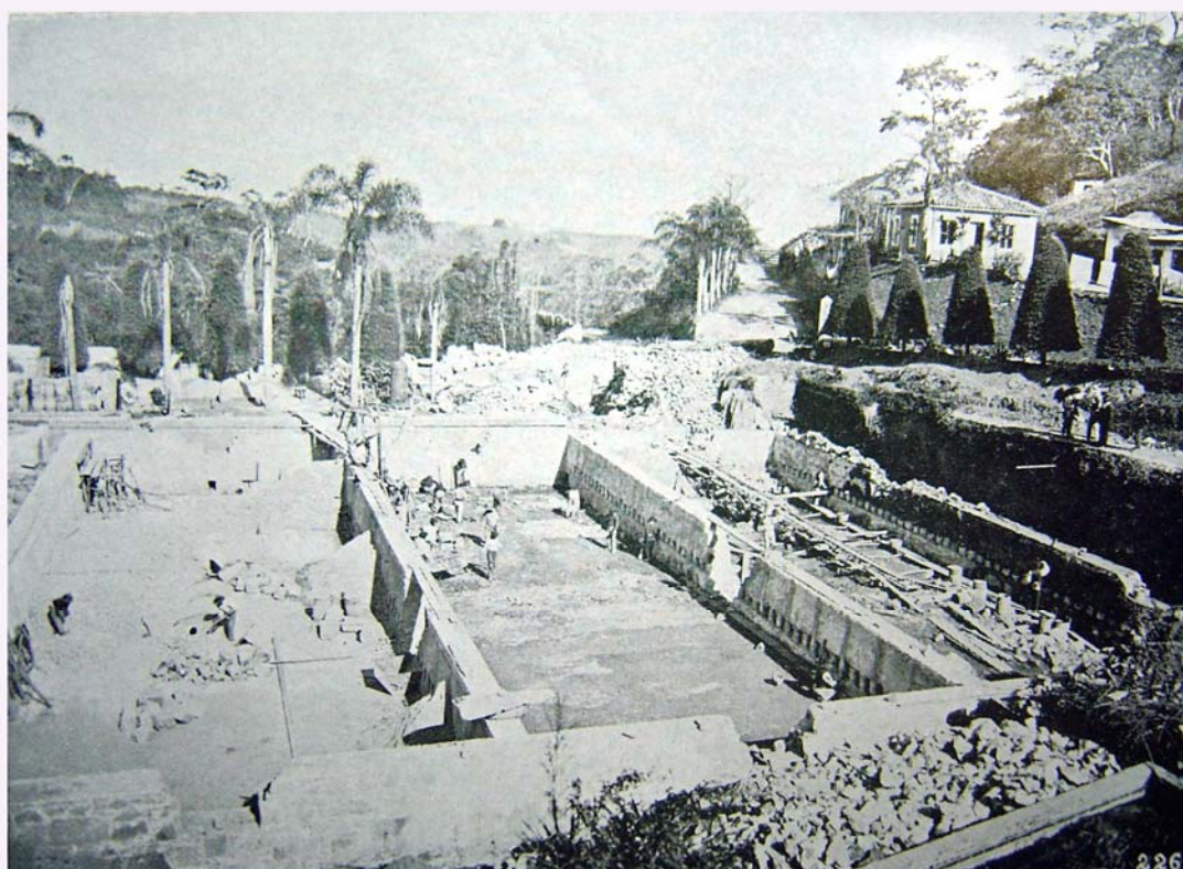
Construção do clarificador do Guarahú
