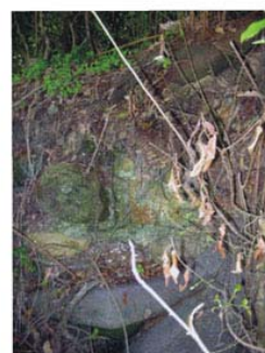
Detalhe da face exterior da parede leste
