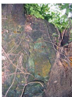
Detalhe da face interior da parede leste
