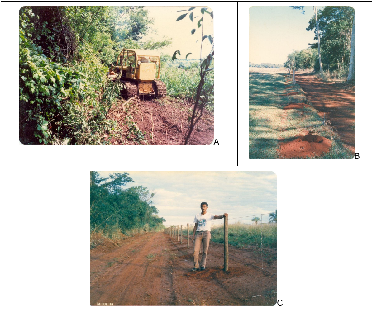
Figura 3.6. Serviço de construção de cerca e aceiro na Estação Ecológica de Paulo de Faria. A: trator realizando aceiros em fevereiro de 1988; B: mourões sendo colocados, sem data; parte da cerca pronta em julho de 1989. (Fotos: José de Arruda Bertoni, 1988, s/d, 1989)
