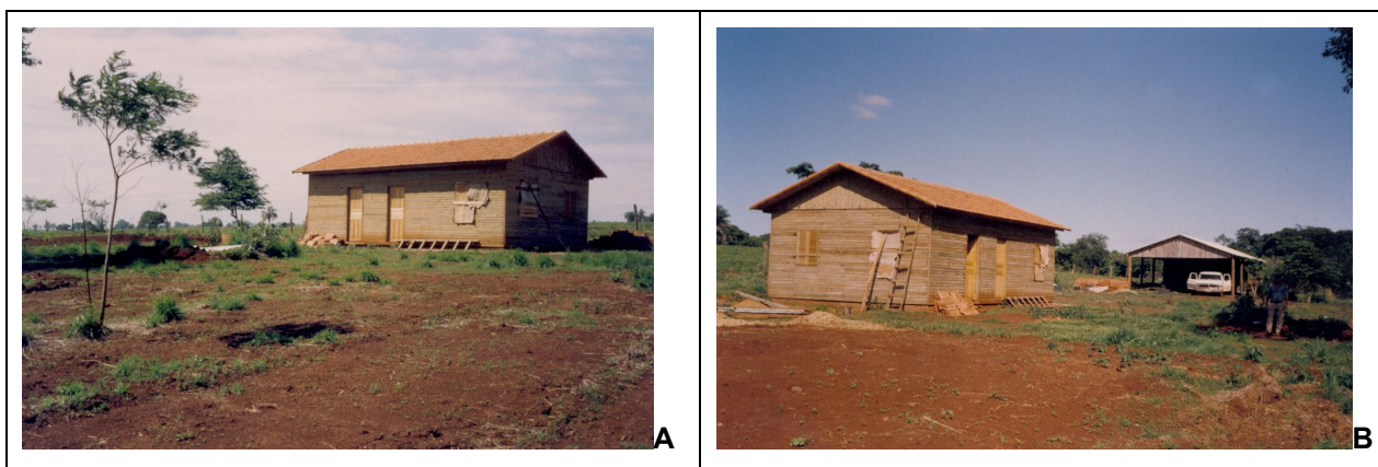
Figura 3.7. Estado da casa de funcionário da Estação Ecológica de Paulo de Faria, em 1994. (Foto: José de Arruda Bertoni, novembro de 1994)
