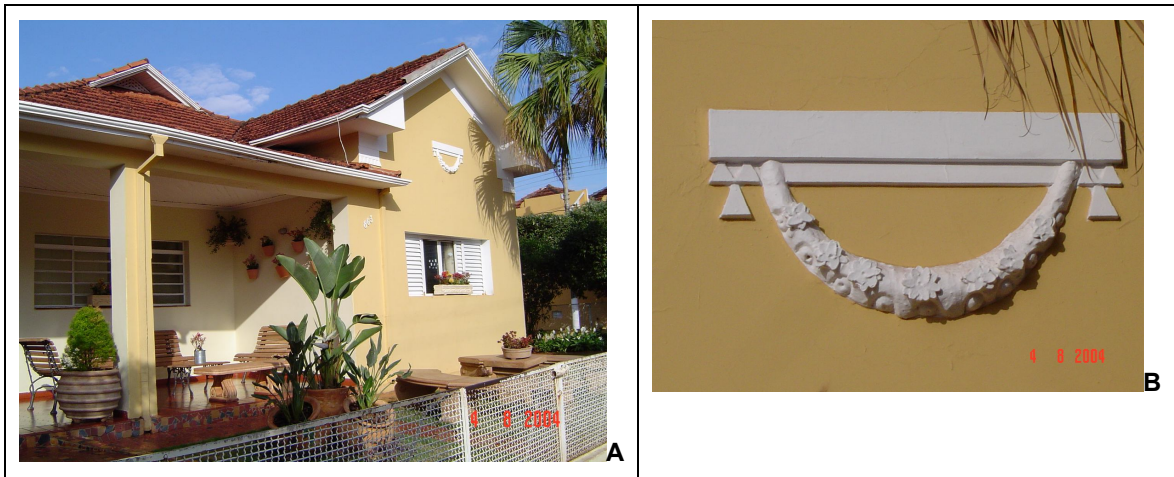
Figura 2.20. Residência de D. Isolina Nunes de Lima, dos anos de 1940, com o detalhe em gesso (Fotos: Instituto Florestal, 04/08/2004).
