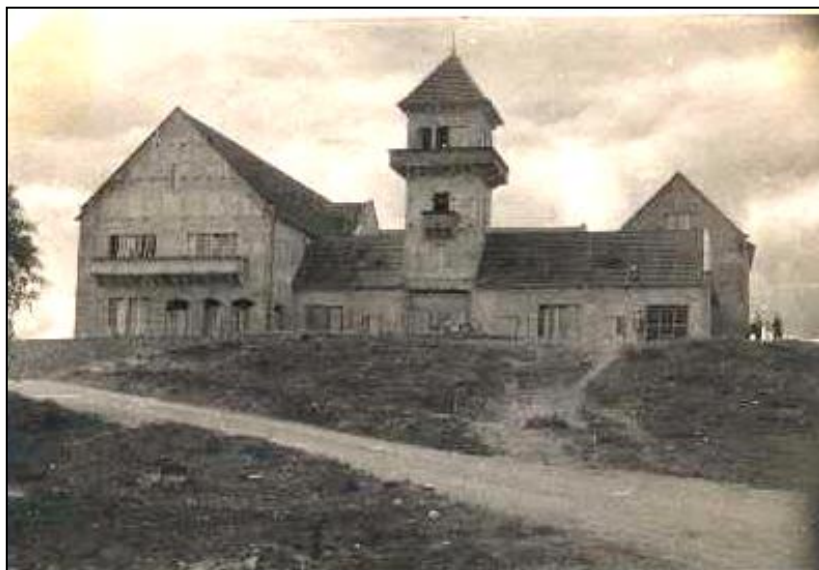
Figura 55 - Palácio Boa Vista, em construção
