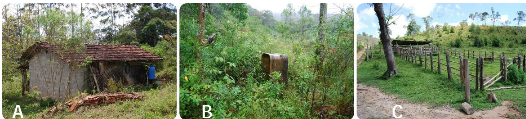
Figura 81. (A) Telhas e outros materiais soltos. (B) Caixa d'água de fibrocimento. (C) Curral e cercas.
