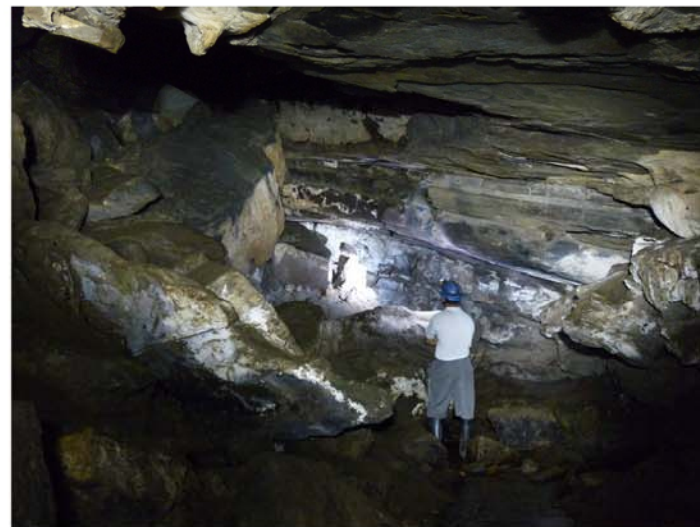
Foto 4. Aspecto geral da porção final da cavidade exibindo o deslocamento de blocos.
