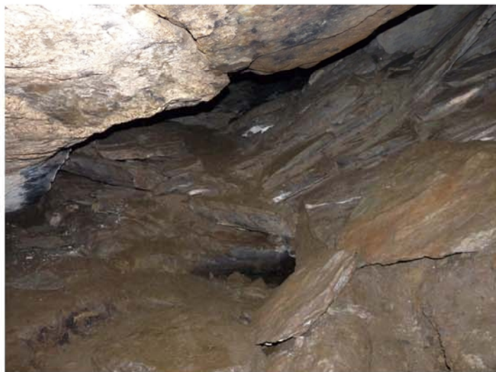
Foto 3. Desplacamento de blocos segundo a foliação principal da rocha encaixante.
