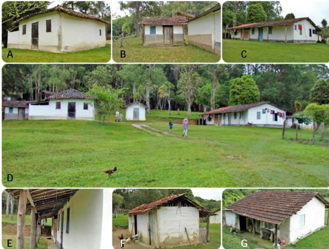
Figura 41 – Bairro dos Paulo: (A) Aspectos gerais da residência 01. (B) Aspectos gerais do depósito anexo à residência 01. (C) Vista geral da construção da residência 02. (D) Aspectos gerais do bairro dos Paulo. (E) Aspectos da varanda lateral. (F) Vista geral da cozinha. (G) Vista geral da residência 3.
