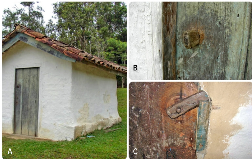
Figura 42 - (A) Aspectos gerais da Capela. (B) Detalhe externo tramela. (C) Detalhe interno tramela.
