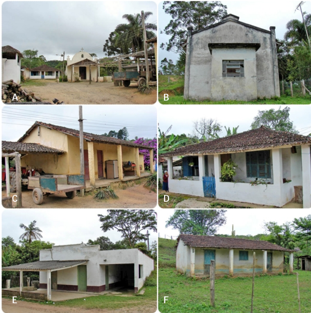
Figura 60 - (A) Vista geral do povoado da Família Boava. (B) Vista frontal da Igreja. (C) Aspectos gerais do edifício que abrigava a antiga escola. (D) Aspectos gerais da residência da Família Boava. (E) Aspectos gerais do armazém. (F) Vista frontal do imóvel.
