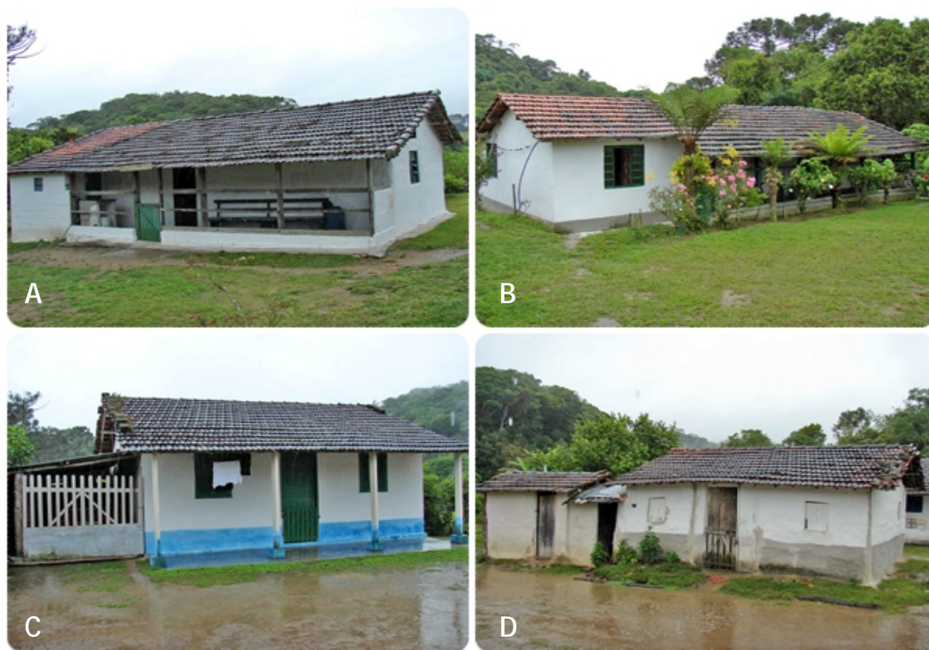
Figura 44 - (A) Aspectos gerais da residência 5, bairro dos Paulo. (B) Vista geral da residência 6, bairro dos Paulo. (C) Fachada frontal da residência 7. (D) Aspectos gerais da residência 8, bairro dos Paulo.
