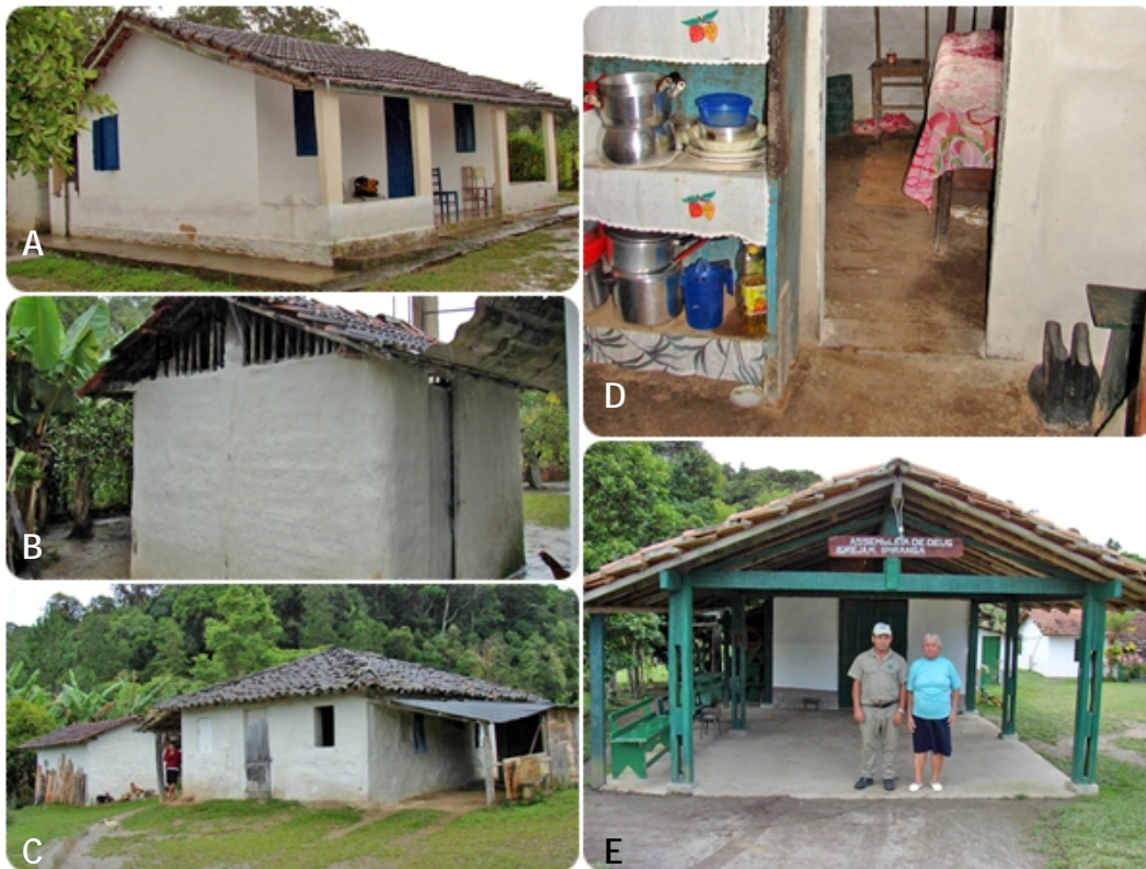
Figura 45 - (A) Aspectos gerais da residência 9. (B) Detalhe da cozinha em pau a pique anexa a residência 9. (C) Vista frontal da edificação com anexo a esquerda da foto. (D) Espaço interno com o piso de chão batido. (E) Vista frontal da edificação com o Sr. Isaías e Sr. Diolinda
