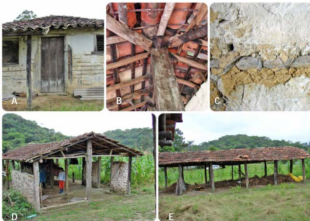
Figura 43 - (A) Fachada frontal da residência 4. (B) Detalhe do madeiramento (cobertura). (C) Detalhe da técnica construtiva (amarração com cipó São João). (D) Rancho utilizado como depósito. (E) Rancho utilizado como celeiro.
