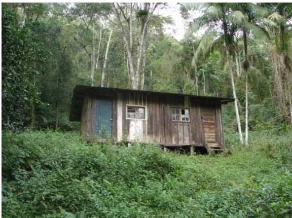
Casa de apoio à manutenção de estradas
