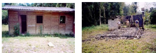
Antiga casa de vigilância e, em 2006, após depredação
