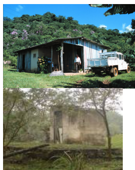
Antiga casa da vigilância (2001) e após as depredações
