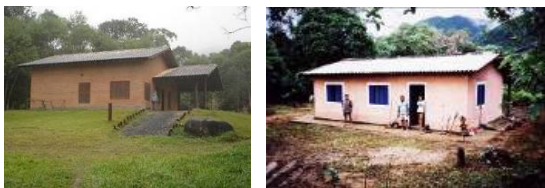
Casa de vigilância PPMA e casa da zeladoria reconstruída
