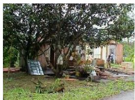
Demolição da casa em 2001
