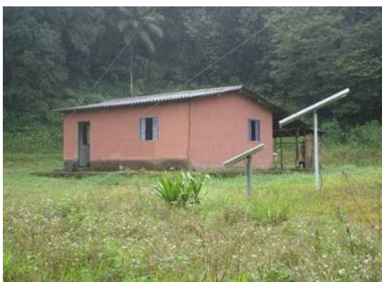
A edificação reformada
