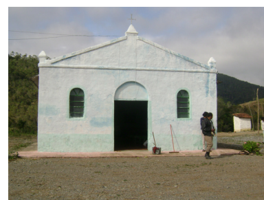
Foto 33 - Capela do bairro Capinzal (Foto: Maria Cristina M. Lima)
