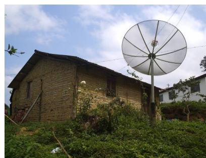
Foto 50 - Residência em pau-a-pique, construção típica do Médio, Alto Ribeira - populações caipiras (Foto: Maurício A. Marinho)
