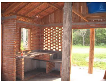
Fotos 47 - Novas casas em construção através do CDHU (Foto: Edmundo)
