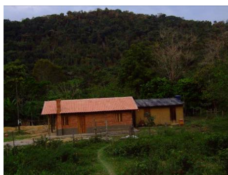
Foto 39 - Residências antigas em taipa de pilão e nova residência, em construção pelo CDHU, ao lado de casas antigas de moradores reconhecidos pelo ITESP (Fotos: Maurício A. Marinho)
