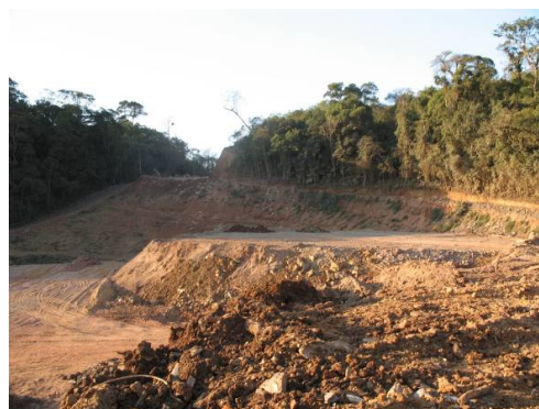
Foto 19 - Implantação do Depósito Estéril onde se localizava o bairro Barro Branco (Foto: Regina Queiroz)
