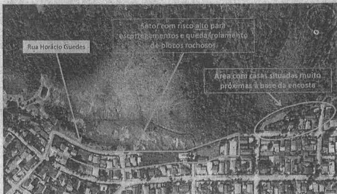
Figura 8 - Delimitação do setor de risco alto para processos de escorregamentos e queda/rolamento de blocos rochosos. Em amarelo, destacam-se casas construídas muito próximas à base da encosta.
