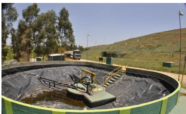
Figura 16: CGR - lagoa de tratamento de chorume(Fonte: Site da Estre)
