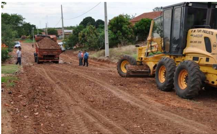
Uso dos restos de construção civil não contaminado para preservação de estradas rurais
