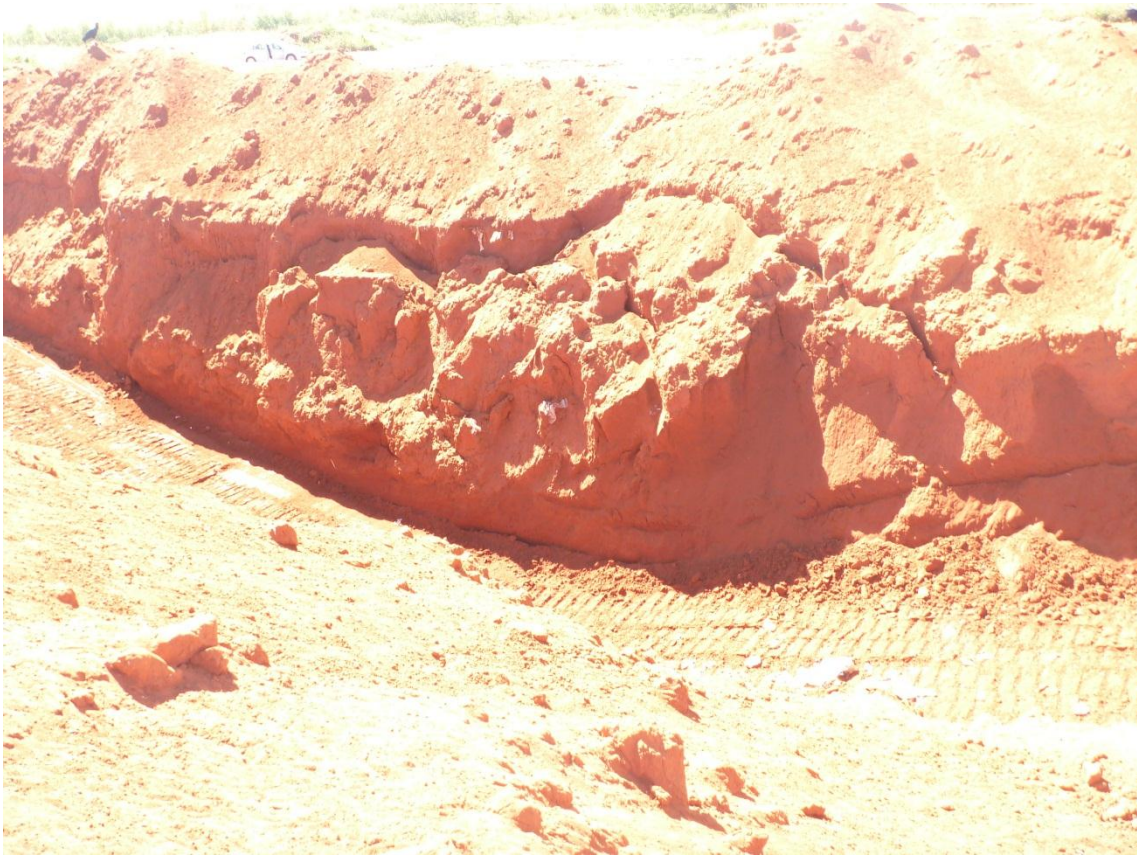
Figura 48 – Detalha do Talude formado na abertura da vala.
