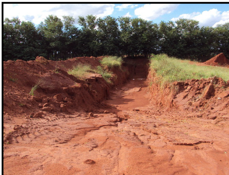
Foto 02 - Sistema de Abertura de Vala Sanitária
