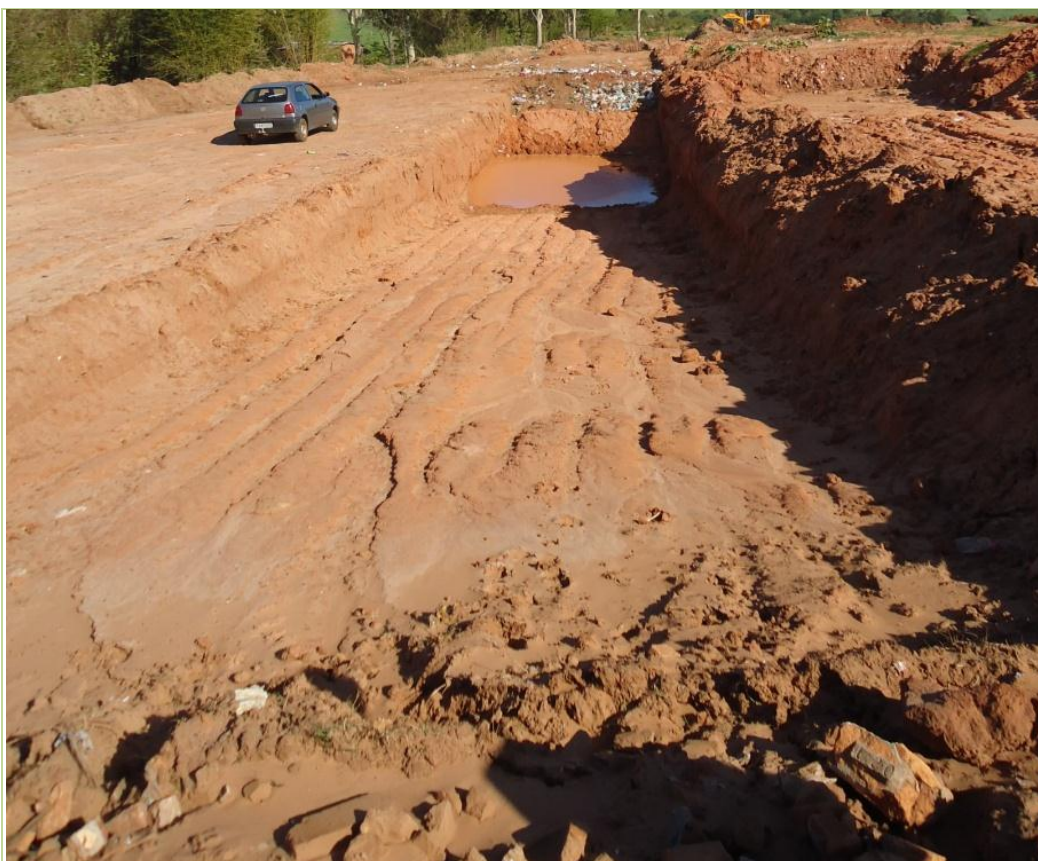
Foto 5 - Dimensões da vala de aterramento
