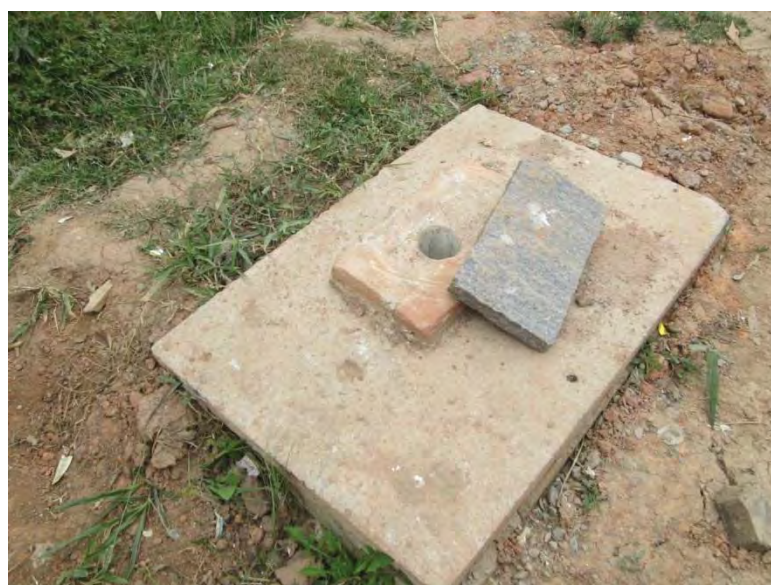
Figura 48: Reservatório de chorume enterrado.
