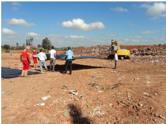
Figura 11.1.1.24. Lona plástica posicionada para o descarregamento do caminhão coletor
