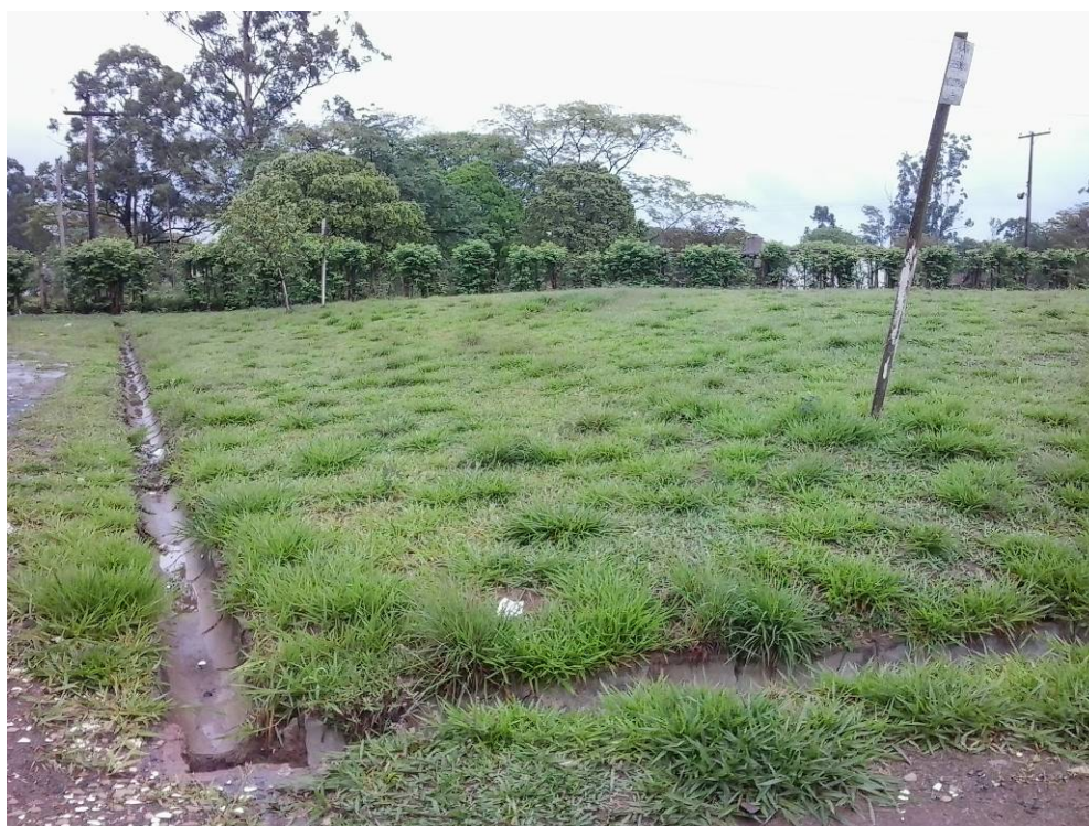
Figura 11.5.2. Canaletas de drenagem pluvial existentes no aterro de resíduos industriais do município de Rio Claro
