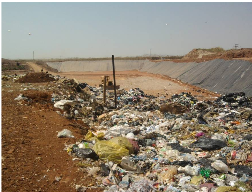
Figura 11.1.1.67. Detalhe do revestimento da manta de PEAD nas laterais das valas
