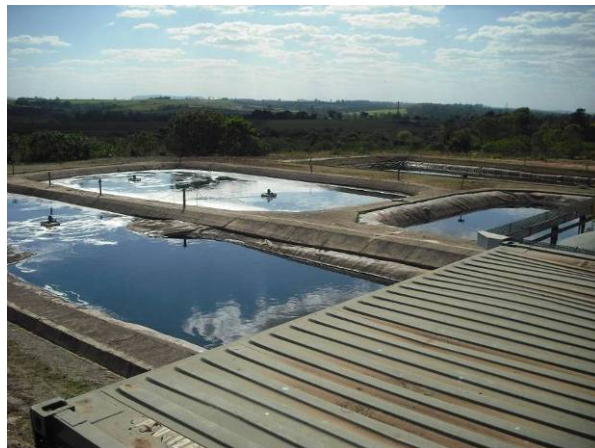
Figura 11.1.1.71. Vista das lagoas de chorumes existentes no aterro sanitário do município de Rio Claro
