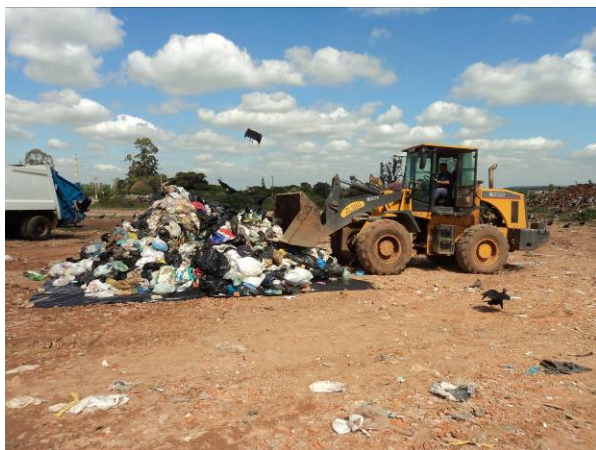
Figura 11.1.1.10. Resíduos sendo espalhados na lona com auxílio de pá carregadeira
