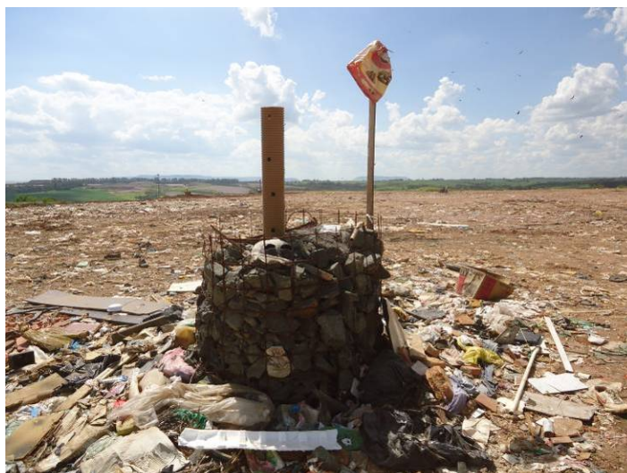
Figura 11.1.1.68. Dreno de gás existente no aterro sanitário de Rio Claro
