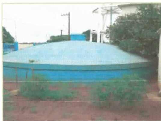
Foto 12 – Reservatório enterrado de 350 m 3
