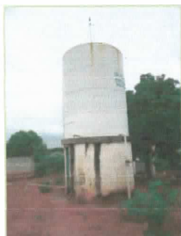
Foto 16 - Reservatório elevado de 30 m 3
