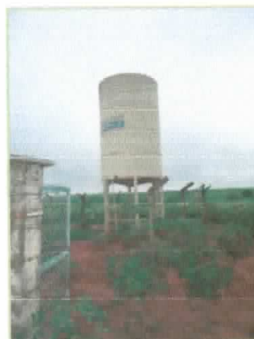
Foto 17 – Reservatório elevado de 40 m 3
