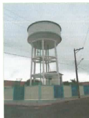
Foto 13 – Reservatório elevado de 150 m 3
