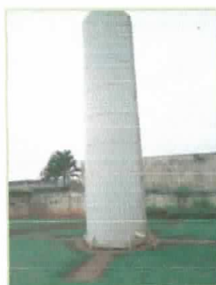
Foto 14 – Reservatório elevado, de 50 m 3
