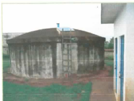
Foto 15 – Reservatório semi-enterrado, de 150 m 3
