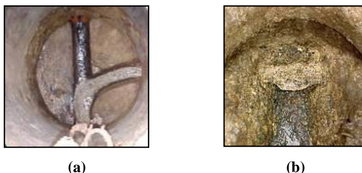
Figura 11.1 – a) Poço de visita limpo. b) Poço de visita obstruído (massa de resíduos e óleo)
