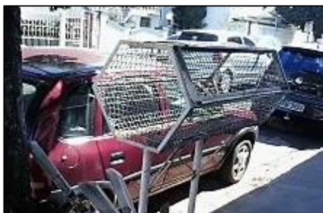
Figura 5.1 – Suporte de aço para acondicionamento de sacos de resíduos provido de tampa
