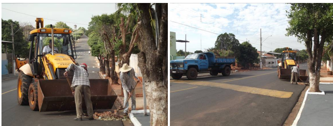
Fotos 12 e 13 – Retroescavadeira, dois auxiliares e caminhão basculante realizando a coleta dos Resíduos de Construção Civil
