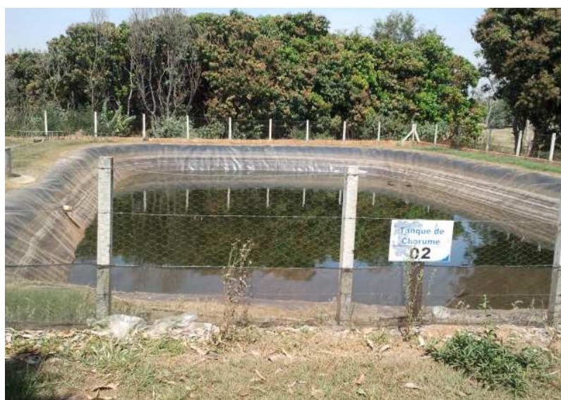
Figura 15 – Tanque de chorume do aterro municipal
