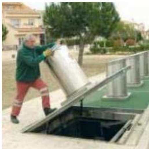
Figuras 10 e 11 — Sistema de coleta e manejo dos containers subterrâneos Fonte: G1.Globo.com, 2010
