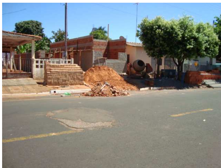
RESIDUOS DA CONST. CIVIL DISPOSTOS INADEQUAD/E EM LOGRADOUROS PUBLICOS.
