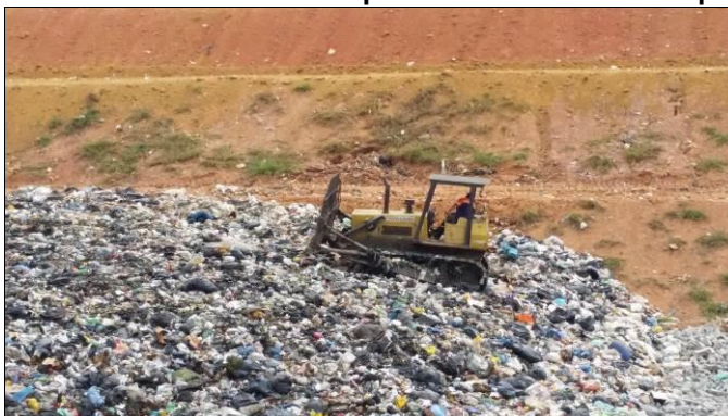
Figura 32: Resíduos sendo compactados na célula em operação.
