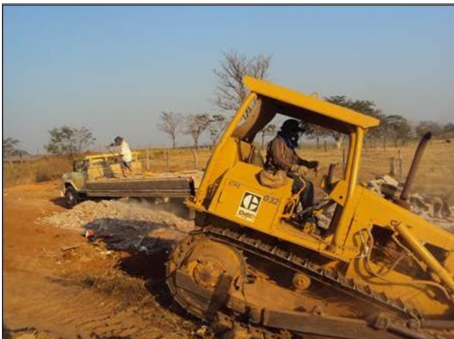
FIGURA 06 – RCC – Compactação de resíduos – 11.08.2010
