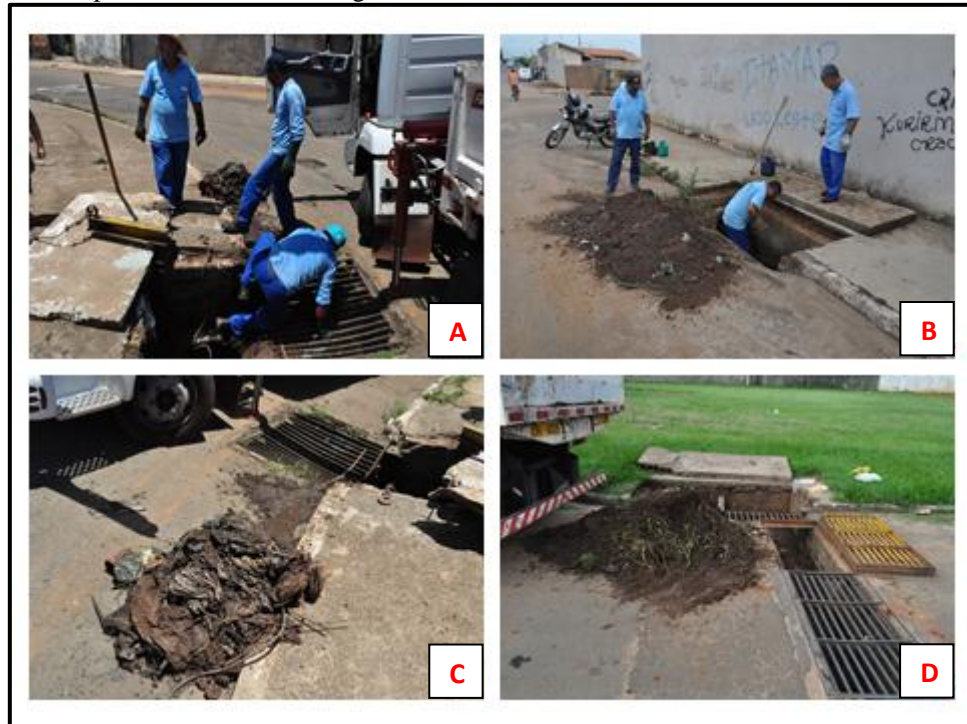
A e B: Funcionários da SAECIL realizando a limpeza de bocas de lobo e galerias. C e D: sujeira retirada das bocas de lobo e galerias. Fonte: SAECIL, 2014.
