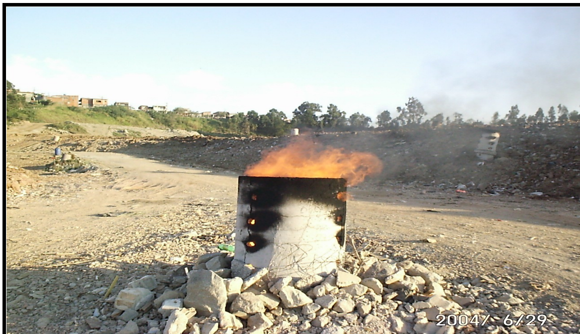
Foto 6.1. - Dreno de biogás em operação no aterro sanitário de Osasco, em São Paulo.
