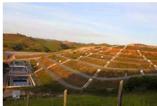
FIGURA 15 – REDE DE DRENAGEM DO ATERRO SANITÁRIO
