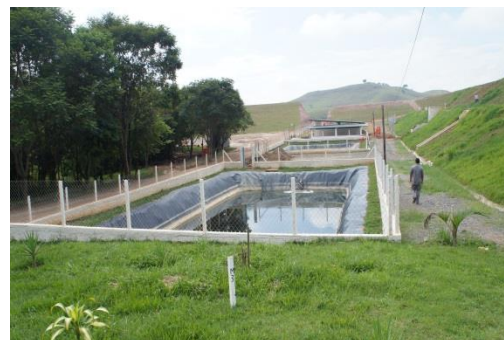
FIGURA 17 – ESTAÇÃO DE PRÉ-TRATAMENTO DE CHORUME
