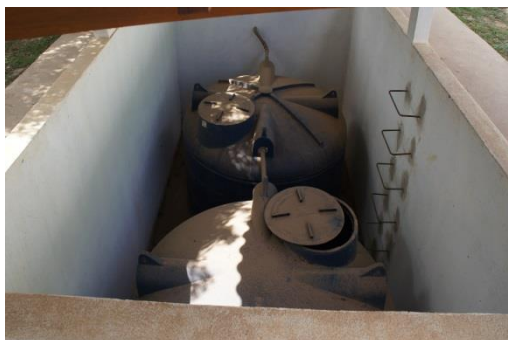
FIGURA 76 – RESERVATÓRIO DE CONTENÇÃO
