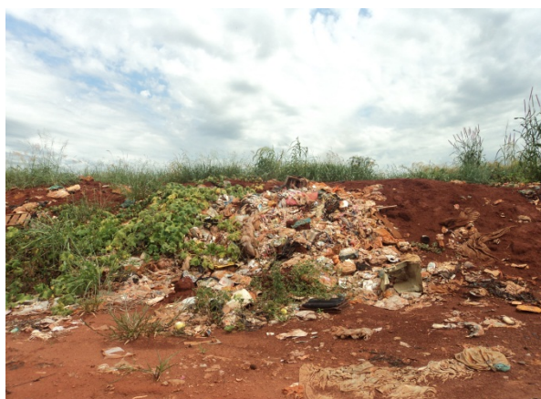
Figura 8.1.90. Detalhe para pequena quantidade de cobertura de terra e com resíduos espalhados no solo.
