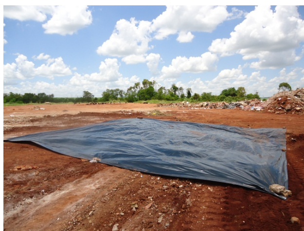
Figura 8.1.2. Instalação da lona plástica no aterro.
