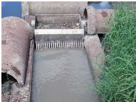
Figura 8.12.1. Local do gradeamento na ETE.
