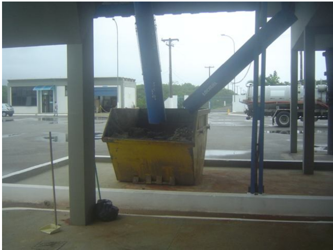
Foto 22- Detalhe da retirada de areia da ETE – Fonte: Prefeitura
