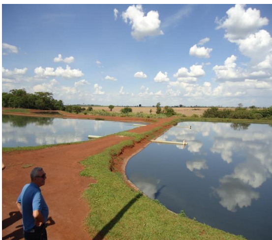
Figuras 7 e 8 - Lagoas de Tratamento do Esgoto da sede do Município, situadas na zona rural.
