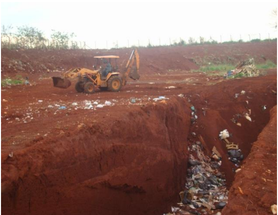
Figuras 42, 43, 44, 45, 46 e 47 - Aterro Sanitário do Município de Ipuã, localizado na zona rural, opera pelo sistema de valas de 03 metros de largura por 03 metros de profundidade. A impermeabilização é através de argila, já que toda área do Aterro Sanitário é composta de solo argiloso.
