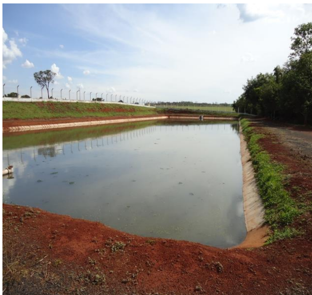
Figuras 9 e 10 - - Lagoas de Tratamento do Esgoto do Bairro da Capelinha - (bairro rural de Ipuã).
