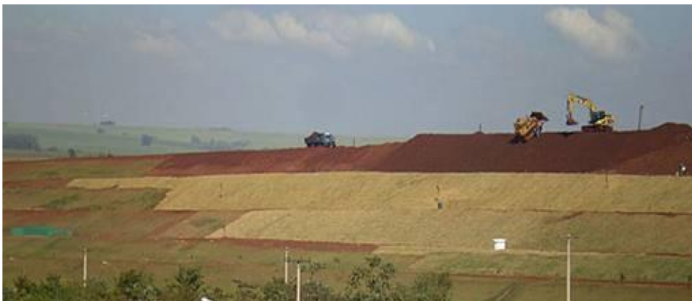
Figura 10.1.33. Regularização dos taludes e plantio de gramíneas.
