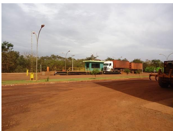
Figura 10.1.19. Balança rodoviária na área do aterro sanitário
