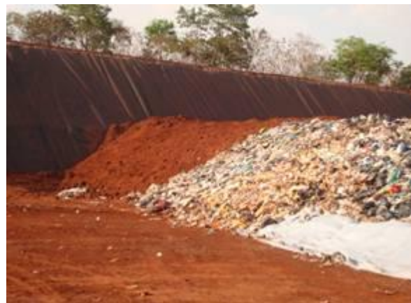
Figura 10.1.24. Impermeabilização lateral da célula
