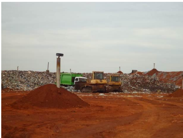
Figura 10.1.23. Compactação dos resíduos em camadas
