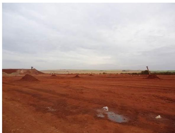
Figura 10.1.28. Queimadores de gás
