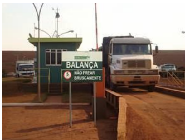
Figura 10.1.18. Balança rodoviária na área do aterro sanitário
