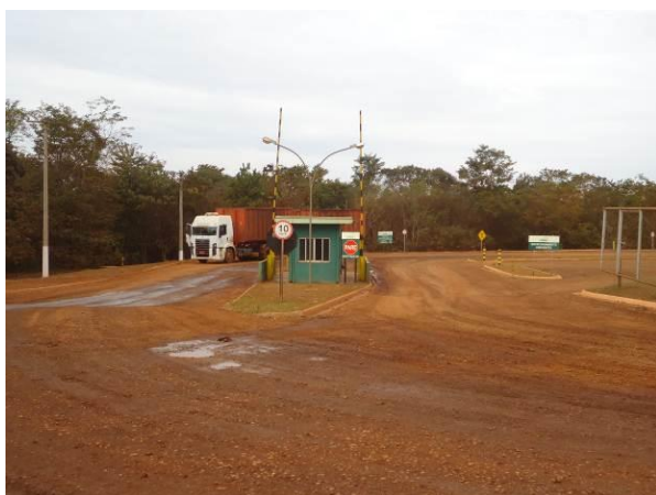
Figura 10.1.17. Vista da Entrada do Aterro Sanitário
