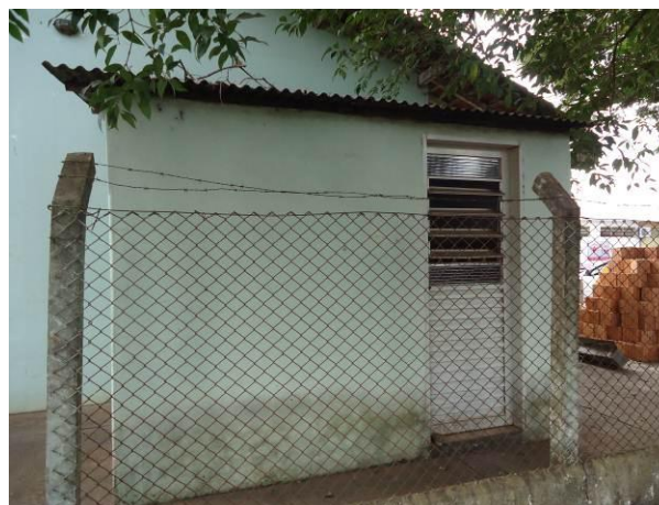
Figura 10.4.14. Local onde são armazenados todos os resíduos de saúde de todo o município
