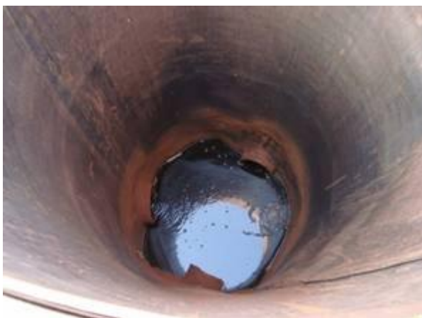
Figura 10.1.25. Sistema de captação de chorume
