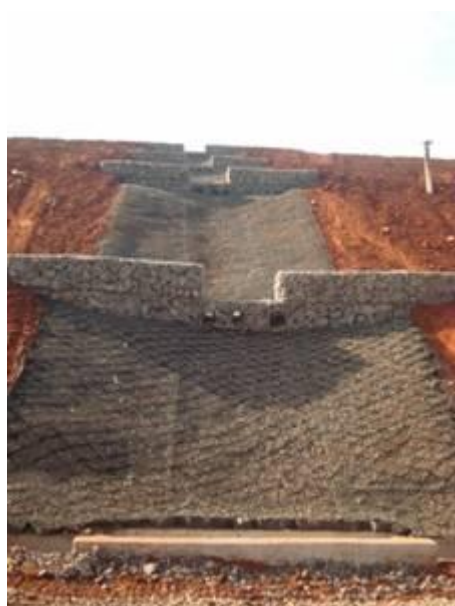
Figura 10.1.29. Sistema de drenagem pluvial
