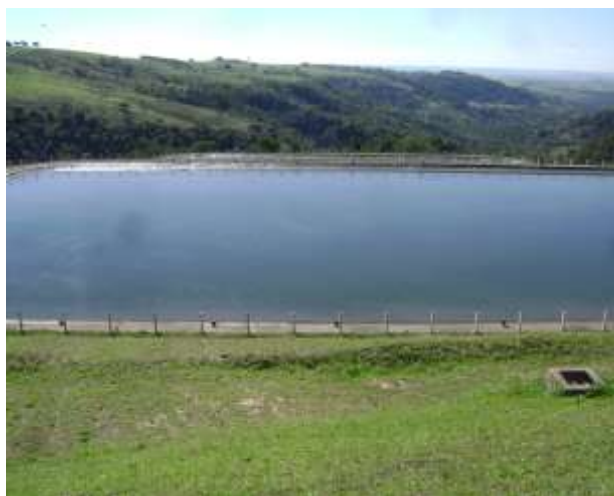
Figura 05: Lagoa facultativa de maturação para tratamento de esgoto de Echaporã. Fonte: CIVAP, 2013.
