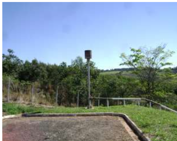
Figura 04: Flare para queima e transformação de metano em dióxido de carbono na ETE de Echaporã.
