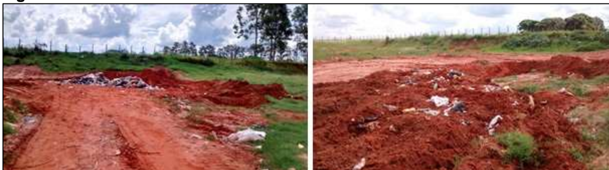
Figura 25 – Aterro controlado em valas.
