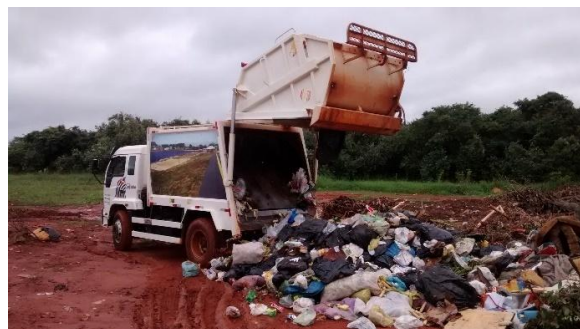
Figura 25 – Aterro controlado em valas.
