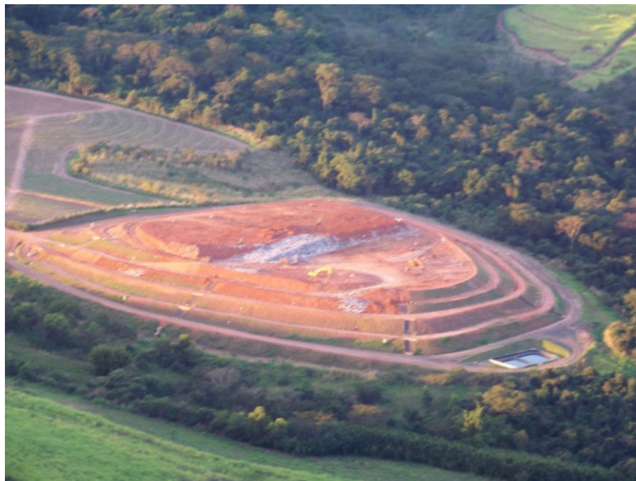
Figura 29 – Vista do aterro sanitário do CGR e da APP do rio Pardinho (acima na foto). Fonte: Prefeitura Municipal de Catanduva (2013).
