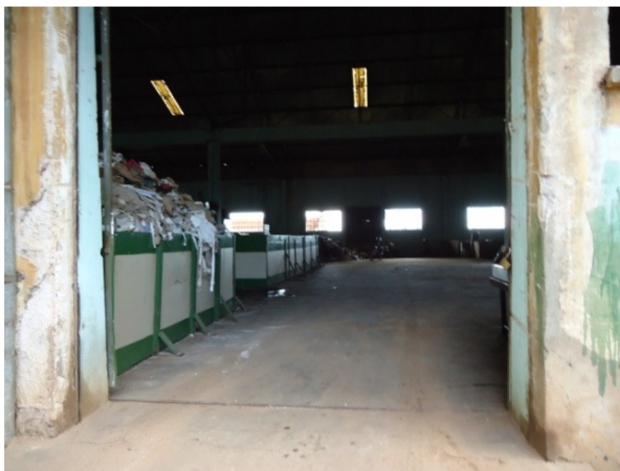
Figura 31 – Galpão do centro de triagem existente. Fonte: SHS (2013).
