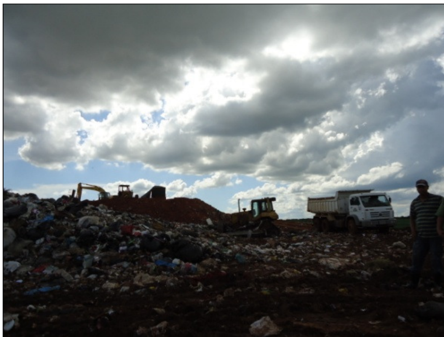
Figura 27 – Aterro sanitário do CGR – frente de trabalho. Fonte: SHS (2013).
