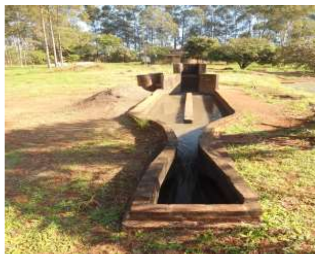
Figura 05: Calha Parshall para medição de vazão na ETE de Cândia Mota.
