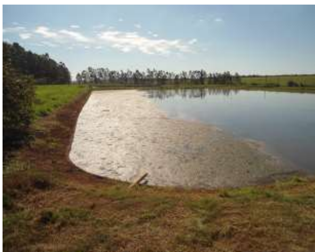
Figura 03: Lagoa facultativa de maturação para tratamento de esgoto de Cândido Mota. Fonte: CIVAP, 2013.
