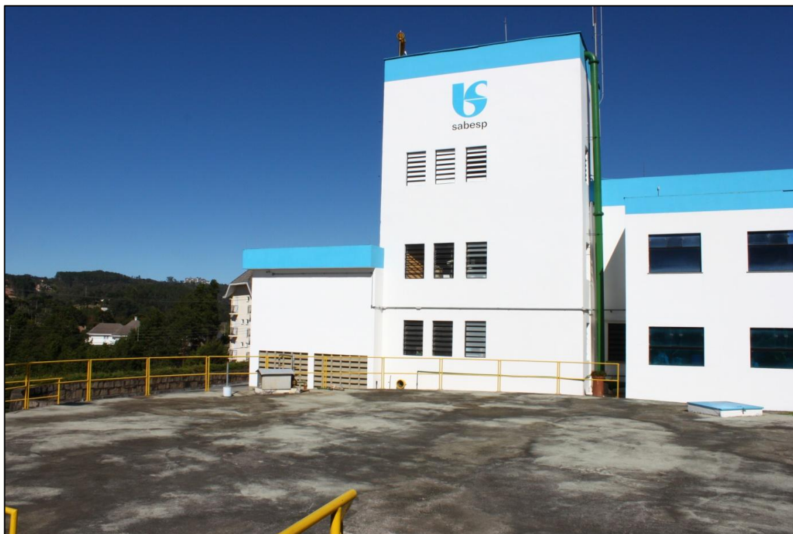
Figura 2.1.4.1.2 - Estação de Tratamento de Água – SABESP
