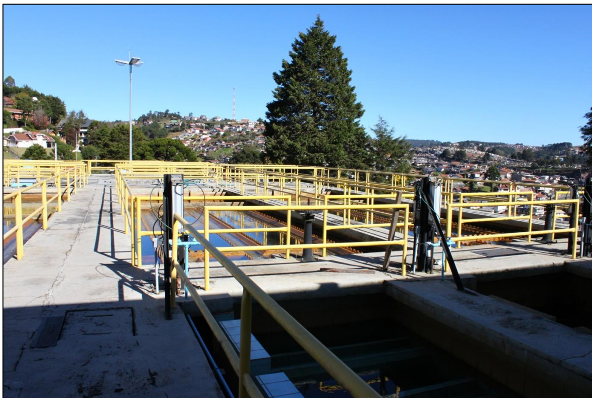
Figura 2.1.4.1.3 – Processos iniciais – floculação, decantação e filtração.
