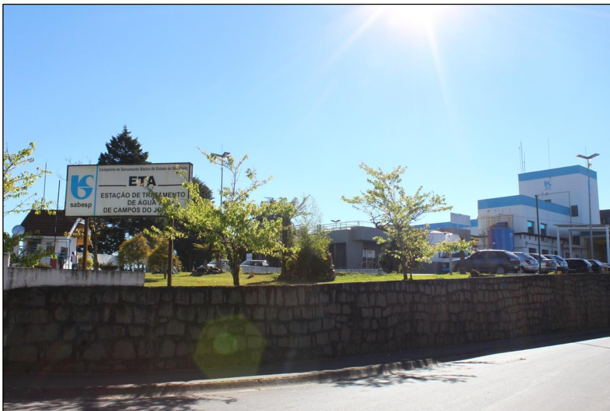
Figura 2.1.4.1.4 – ETA - Saída da SABESP.
