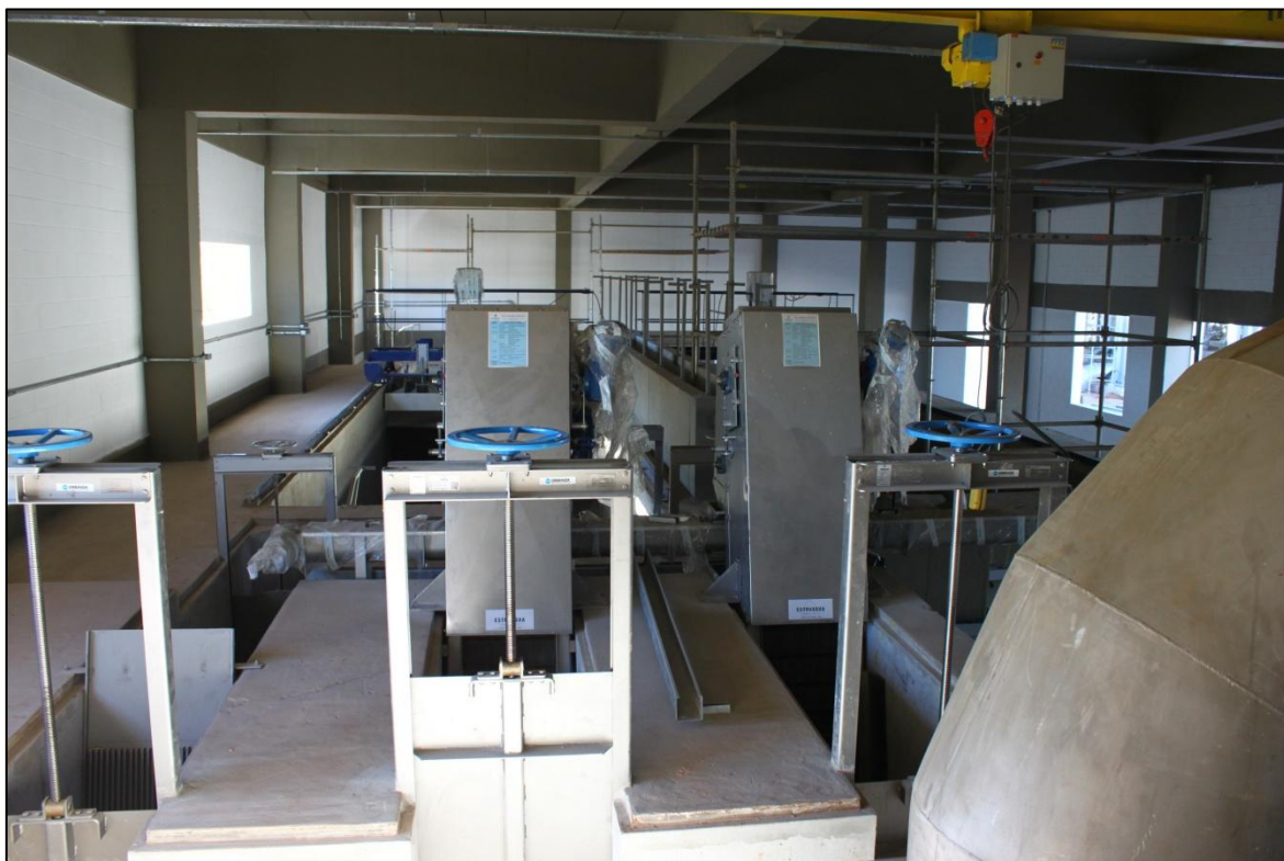
Figura 2.1.4.1.7 - Obras da Estação de Tratamento de Esgoto – ETE.
