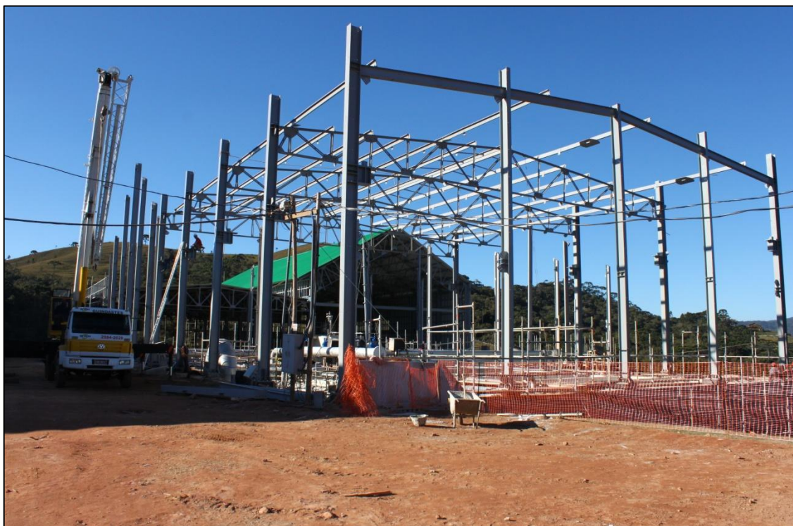
Figura 2.1.4.1.5 - Obras da Estação de Tratamento de Esgoto – ETE.
