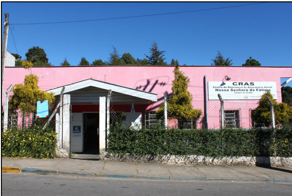
Figura 2.1.3.4.1 - Fachada do CRAS.
