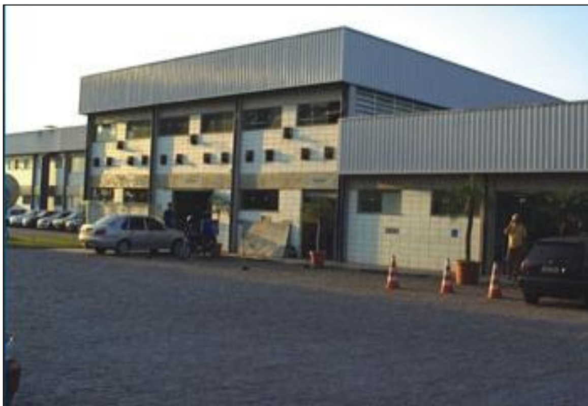
Figura 2.1.4.2.1 - Prédio da Terracom – Cubatão/SP.
