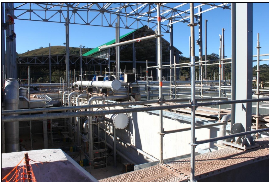
Figura 2.1.4.1.6 - Obras da Estação de Tratamento de Esgoto – ETE.
