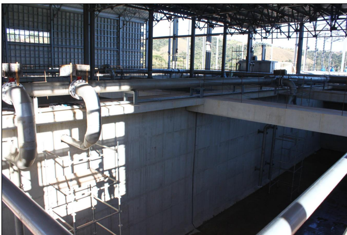
Figura 2.1.4.1.8 - Obras da Estação de Tratamento de Esgoto – ETE.
