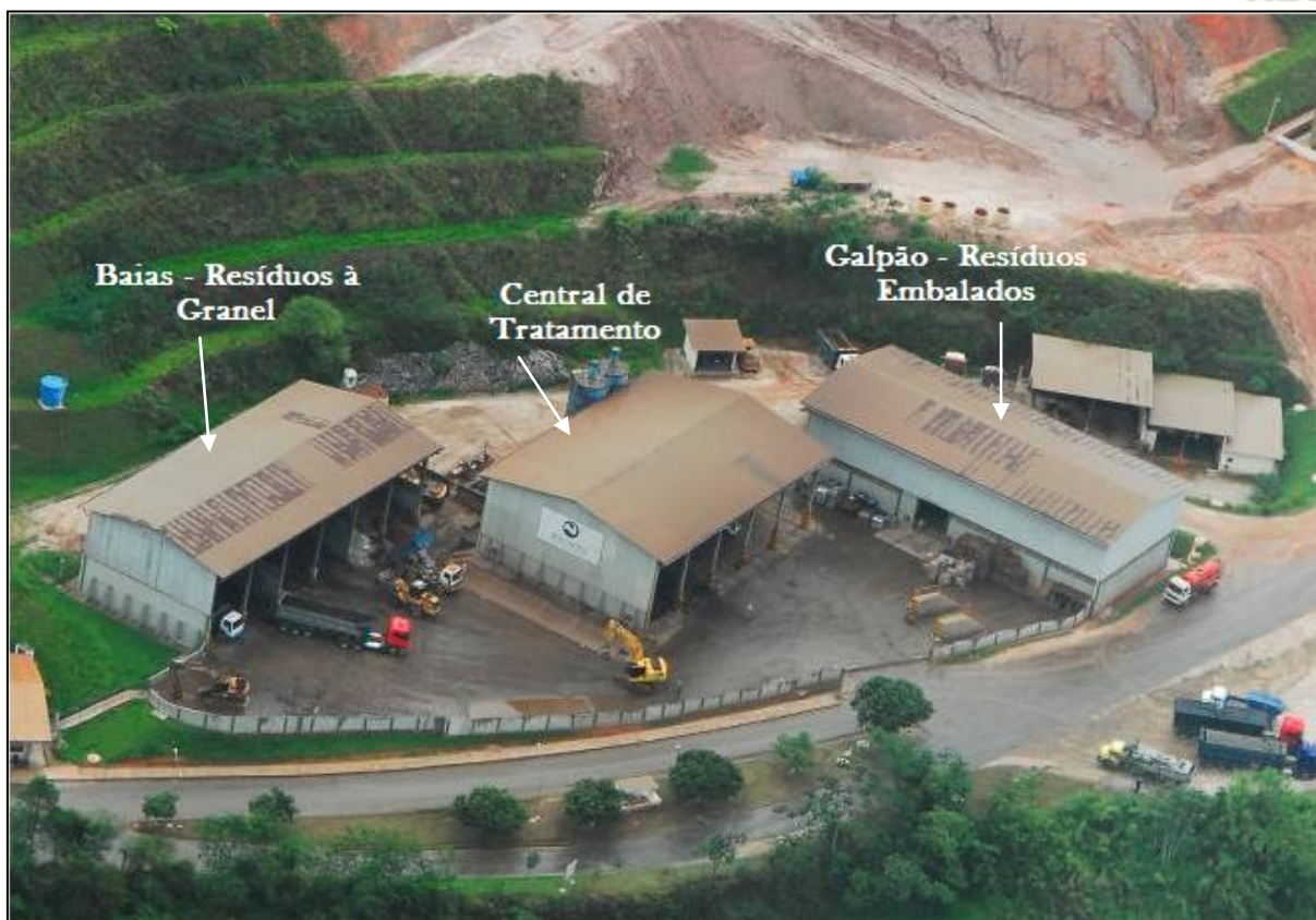
Figura 3.3.1.3.6 - Galpões de Armazenagem e Tratamento
