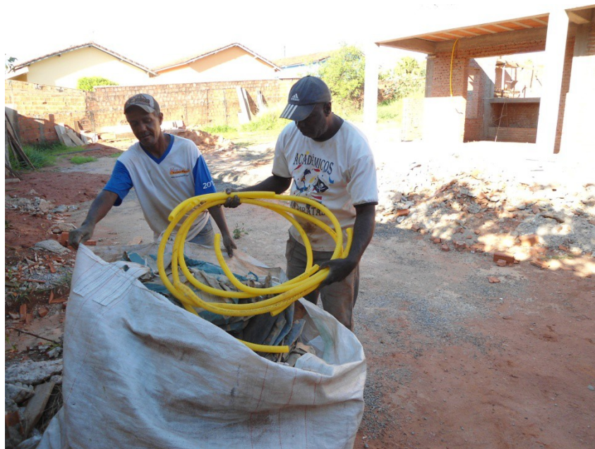
Foto 3. Trabalhadores separando os resíduos recicláveis em canteiro de obra, utilizando bag doado pela Prefeitura.- Projeto Re-Entulho
