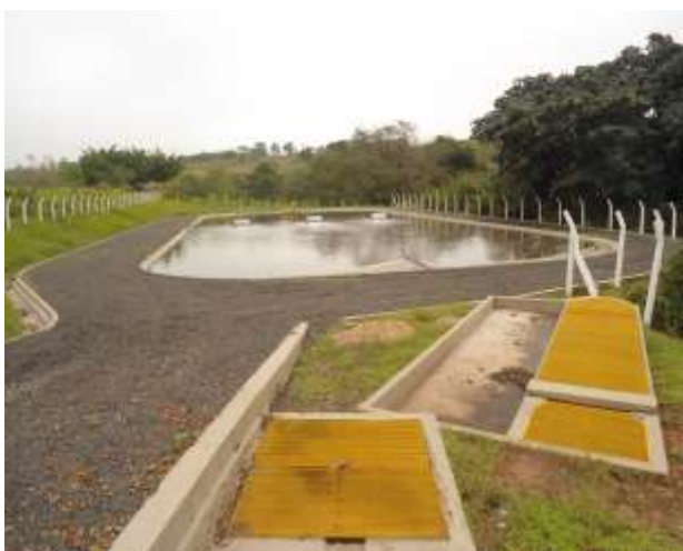
FIGURA 02: Lagoa aeróbica para tratamento de esgoto em Borá.
