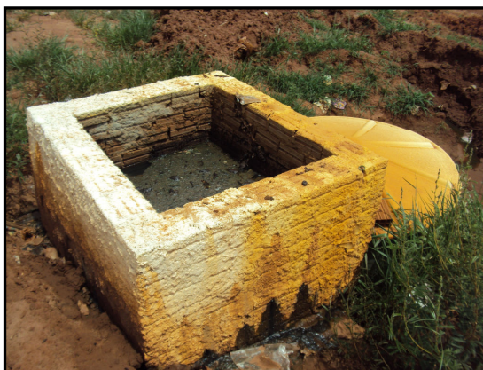
Foto 04 -Caixas de contenção de chorume.
