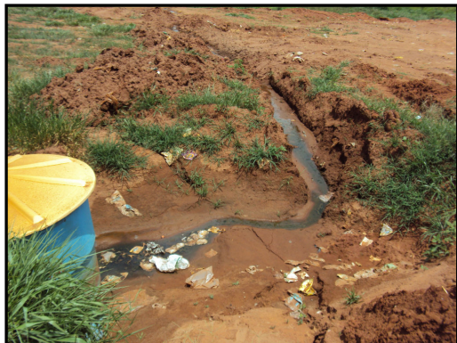
Foto 05 - Caixa de contenção de chorume; acima o pátio de serviço do aterro sanitário.
