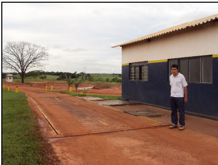
Foto 08 - Balança tipo rodoviária utilizada na pesagem dos caminhões.
