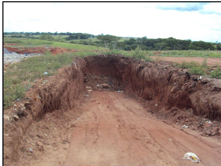
Foto 02 - Sistema de Abertura de Vala Sanitária
