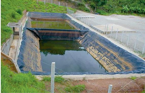
**FIGURA 14** – TANQUE DE ACUMULAÇÃO DE CHORUME EM ATERRO SANITÁRIO.
