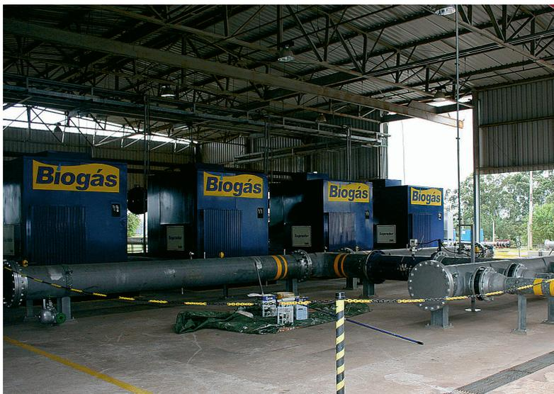
**FIGURA 19** - SISTEMA DE RECUPERAÇÃO ENERGÉTICA DE GÁS DE ATERRAMENTO
