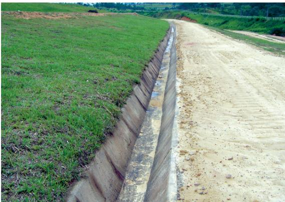
**FIGURA 13** - DRENAGEM DE ÁGUAS PLUVIAIS EM ATERRO SANITÁRIO.
