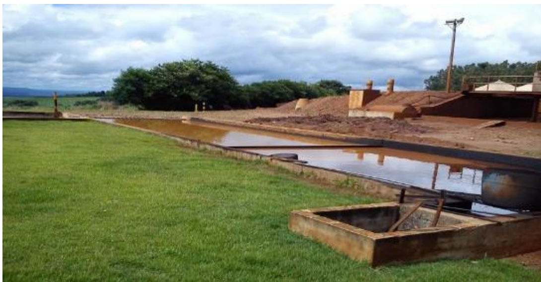
- CAIXA SEPARADORA DE ÁGUA E ÓLEO.
