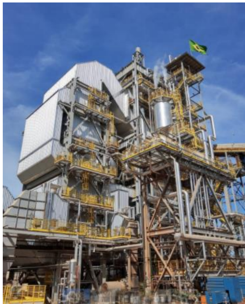
- SETOR CALDEIRA (PRECIPTADOR ELETROESTÁTICO).
