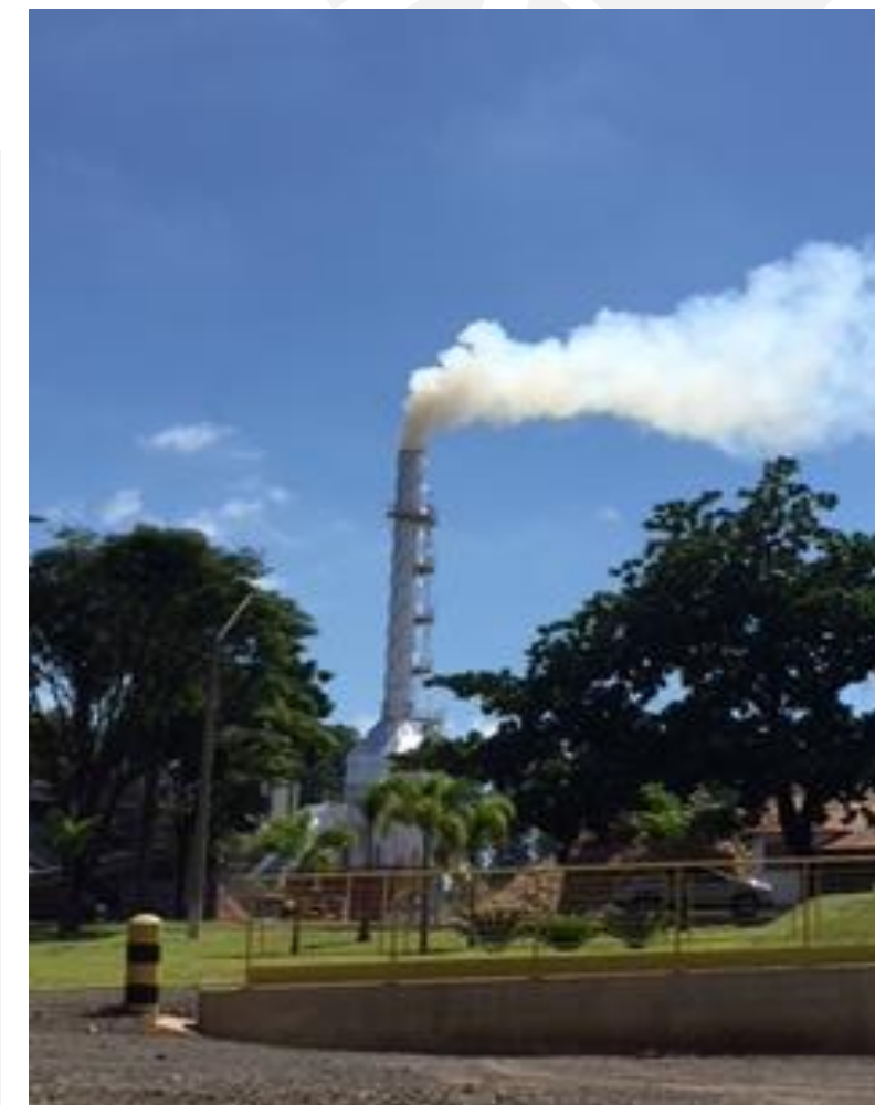
- SETOR CALDEIRA (CHAMINÉ COM LAVADOR DE GASES ).
