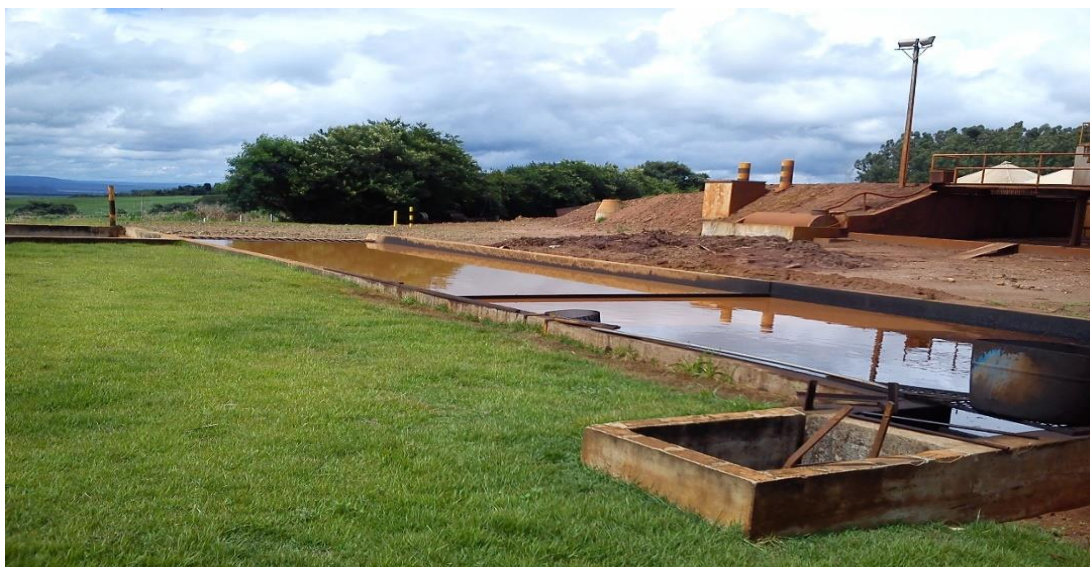
- CAIXA SEPARADORA DE ÁGUA E ÓLEO.
