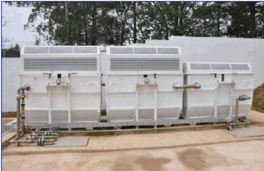
ETE compacta instalada no Recanto Verde do Sul
