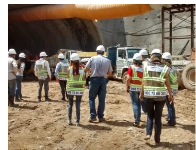
Visita de funcionários da Sede da DERSA aos locais das obras
