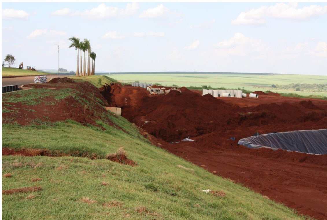
Figura 5: Movimentação de terra para a construção dos tanques que receberão chorume.
