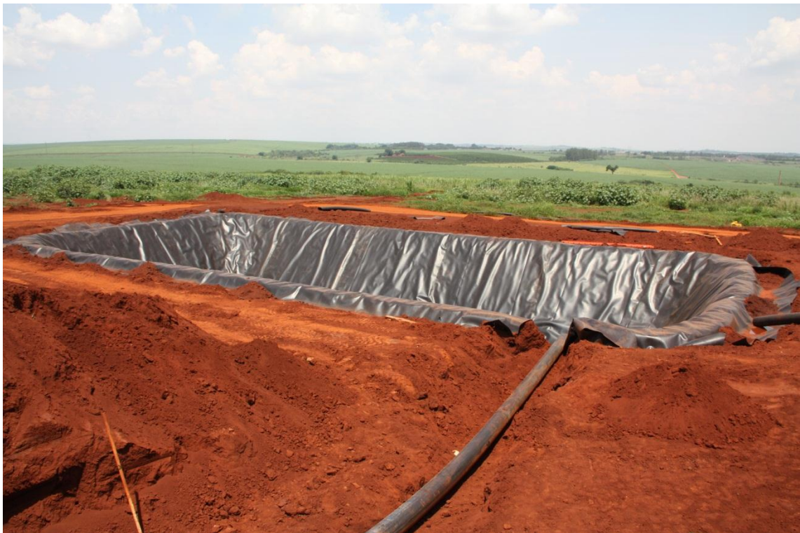
Figura 11: Caixas de retenção dos efluentes gerados (efluente sanitário, chorume, água de lavagem etc).
