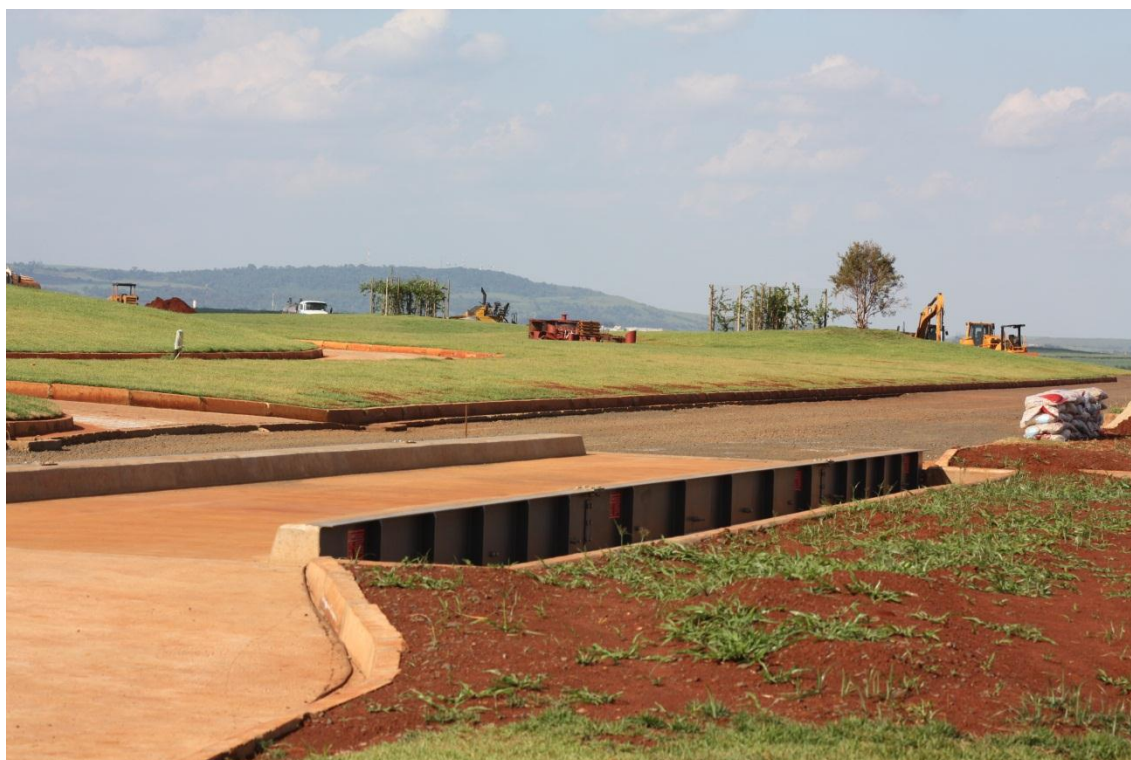
Figura 4: Balança de pesagem dos caminhões, na entrada do CTR Palmeiras.
