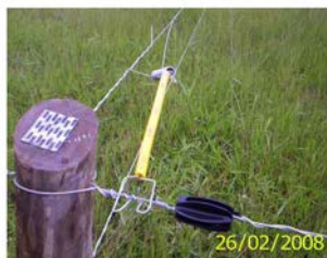
Chave curta (Usada quando a rede é a cerca do corredor). Quando desligada, deve ficar apoiada entre a castanha e o moirão (área isolada).
