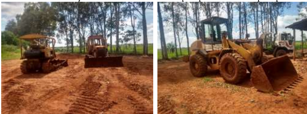
Foto 27 e 28. Maquinários utilizados no aterro
