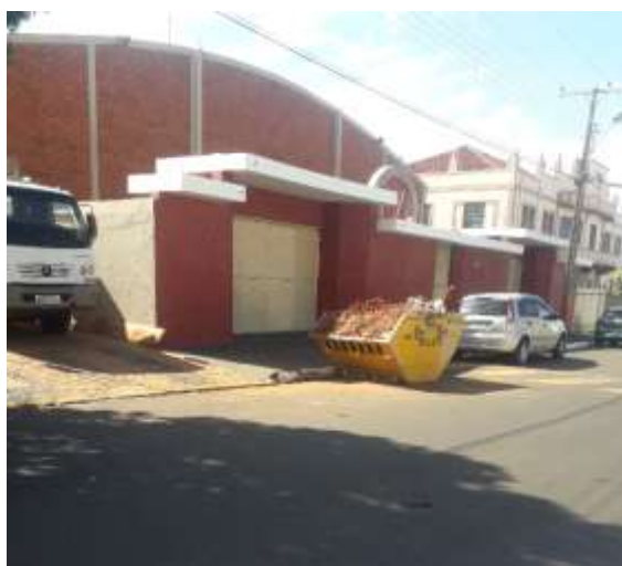
Foto 68- Locação de caçamba particular para resíduos de construção civil
