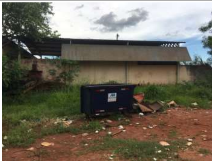
Foto 57. Condições da área externa da Central de Triagem e acondicionamento do rejeito
