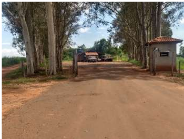
Foto 7. Portão de entrada e guarita no aterro sanitário municipal.
