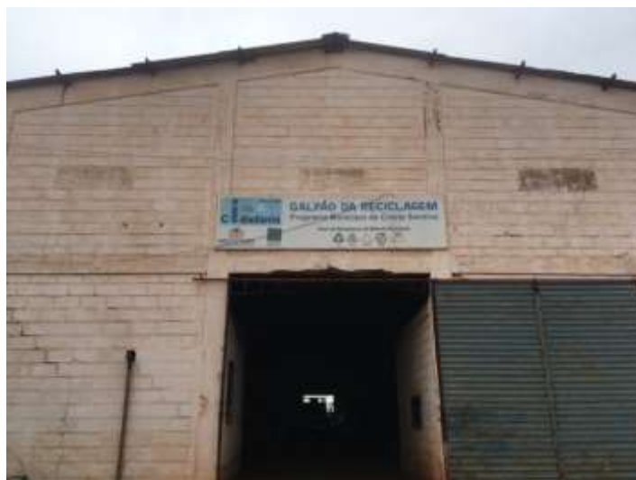
Foto 45. Visão geral do galpão de triagem onde funciona a Associação Lixo & Cidadania.
