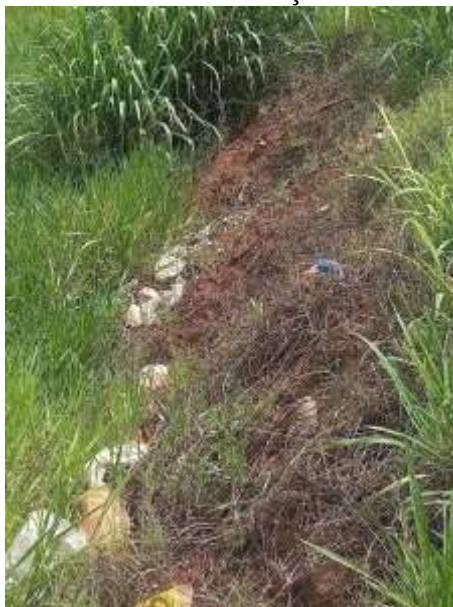
Foto 23.Exposição de resíduos no talude da célula já encerrada
