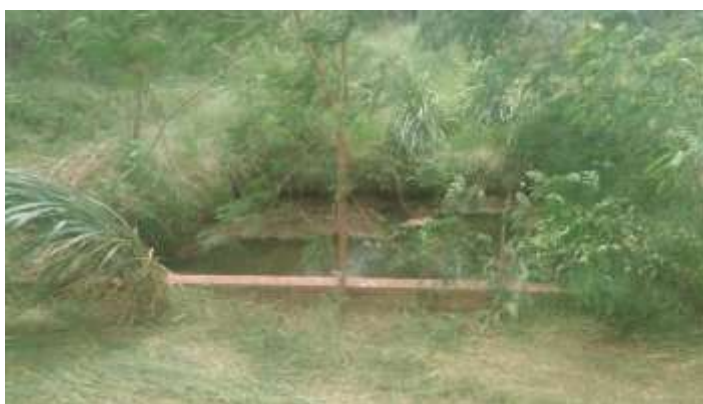
Foto 12. Tanque de contenção de chorume
