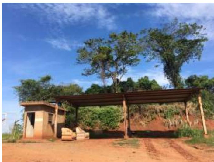
Foto 76. Cobertura para maquinário e banheiro para o vigia
