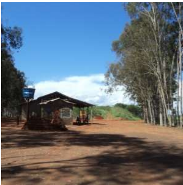
Foto 8. Barracão coberto para abrigo dos maquinários
