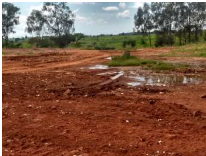
Foto 18 Visão geral da célula de aterramento dos resíduos (resíduos, pontos de acúmulo de água pluvial)
