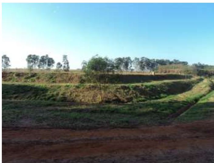
Foto 9. Aterro Sanitário Municipal registrado em 2014
